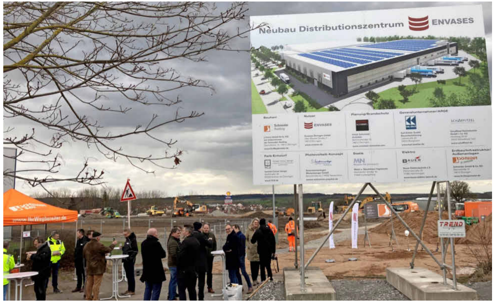
Direkt neben dem Werk II von Envases entsteht bis Jahresende nun die Logistikhalle, welche die Kapazität von vier Außenlagern bündelt.
