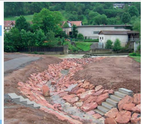
ein neues Stahlbetonbauwerk mit Rechenanlage eingebaut sowie der vorhandene Sohlverbau in Teilabschnitten erneuert. Zusätzlich wurde eine Hangsicherung mit Sandsteinblöcken sowie eine neue Böschungsmauer mit Geländer erstellt.
